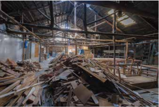
کارگاه متروکه‌ی تولید مبلمان در محدوده‌ی پل چوبی تهران. این ساختمان دوطبقه با حدود هزار متر مربع زیربنا، برای آن‌که به فضایی مناسب برای نمایش تبدیل شود، نیازمند تعمیرات و ایمن‌سازی گسترده بود.
